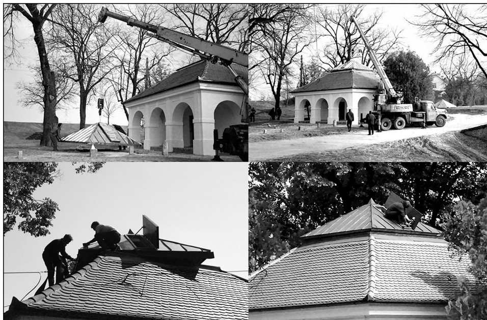
Слика 10: Израда и монтирање треће пирамиде V-3 направљене по пројекту проф. др. Војислава Кујунџић.
