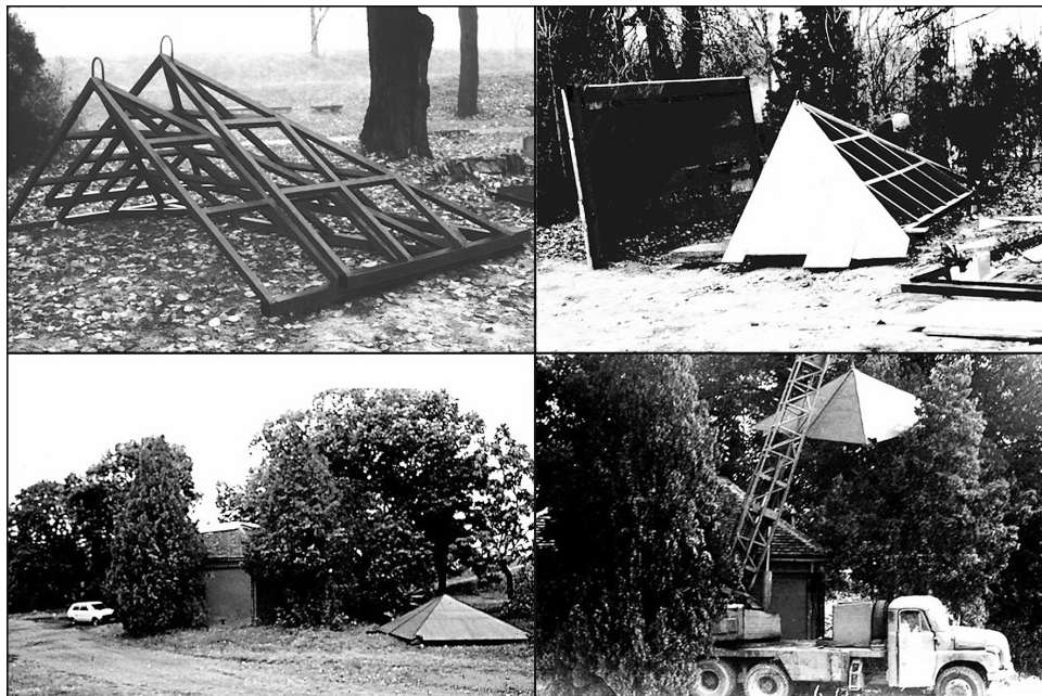
Слика 4: Израда и монтирање прве пирамиде направљене по пројекту инг. грађ. Владе Панића у пролеће 1987.
