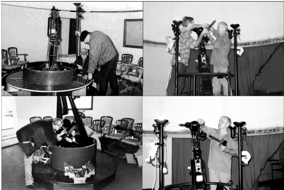
Слика 6: Монтажа пројекционих система на ZKP-1 у току 1999. године.
