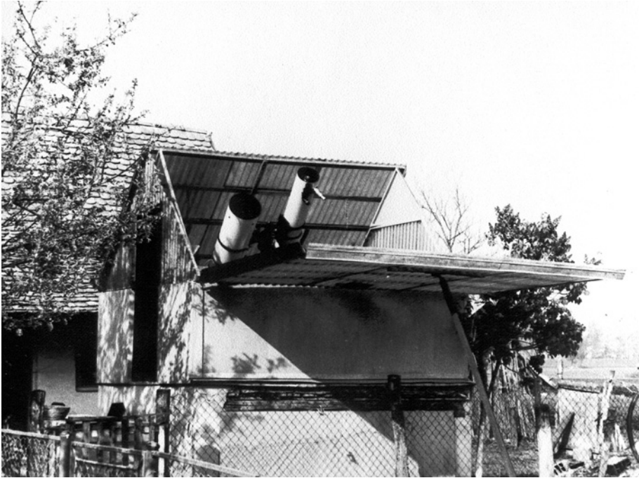
Слика 2: Изглед опсерваторије после реконструкције.
